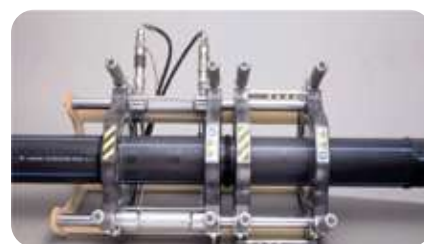
Fase 5: Saldatura con gli elementi in pressione.
